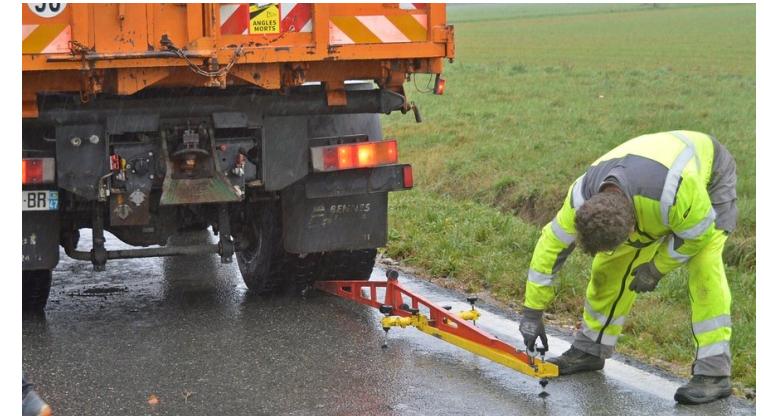
FIGURE 4. Poutre de Benkelman + Camion chargé à 13t
