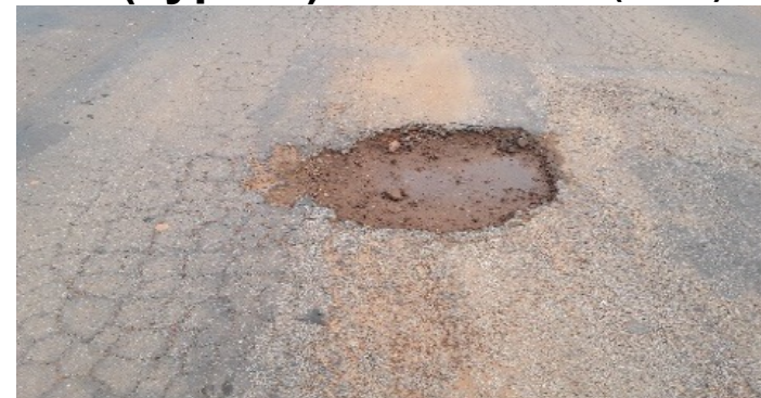
FIGURE 3. Nids de poule – également courant
