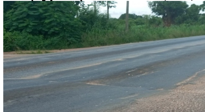
FIGURE 2. Orniérage dans les bandes de roulement – pathologie fréquente
